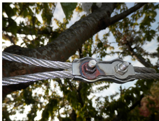
FIGURE 6 – Une attache de filin d'acier en inox dont un écrou n'est pas en inox.
